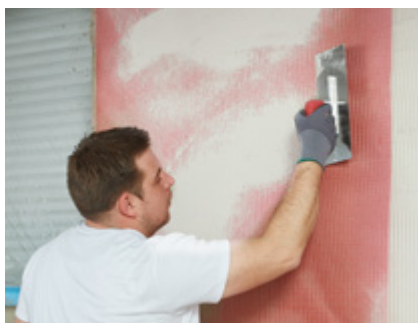
Dämmstoffe armieren
