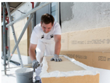
Dämmstoffe kleben
