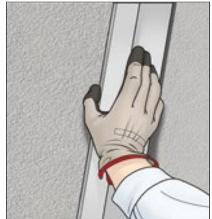
**1** Der Auftrag erfolgt wie bereits beschrieben ein- oder zweilagig. Nach kurzer Standzeit (ca. 3–10 Minuten) sind die Flächen lot- und fluchtrecht mit einer Abziehlatte eben und mit geschlossener Oberfläche zu verziehen.
