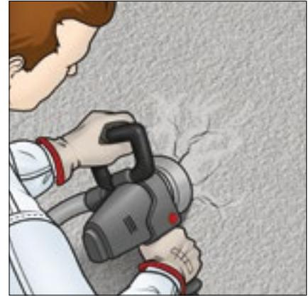
**3** Bei hochstehenden Rissflanken sind diese zu entfernen und beizuputzen.
