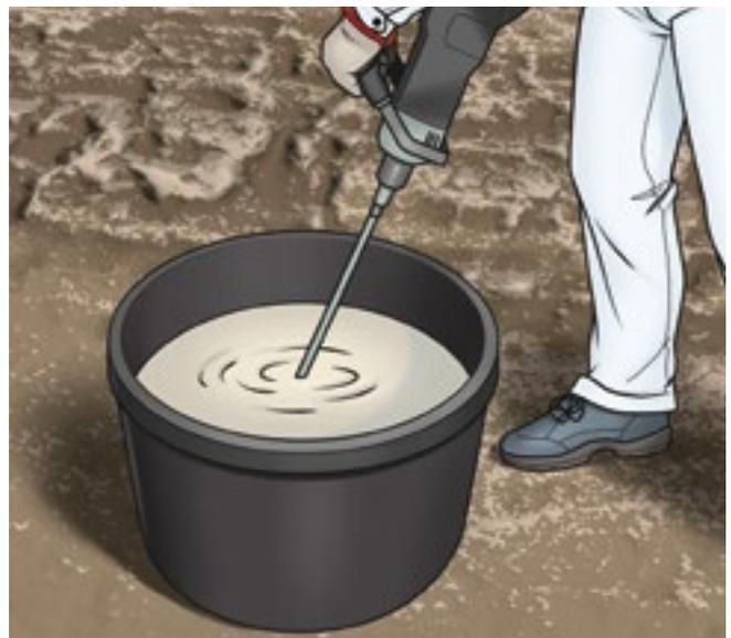
**1** Zum Anmischen von Hand wird der Putz in die vorgegebene Wassermenge eingestreut. Dabei sollte auf Sauberkeit von Wasser und Gefäß geachtet werden.
