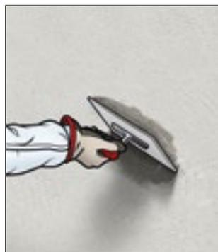
**2** Die Putzlage wird mit einer Traufel auf Kornstärke bzw. die zulässige Schichtdicke abgezogen.
