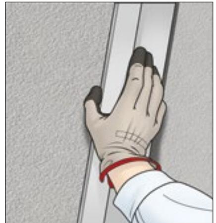
**1** Der zweilagige Auftrag wird nass in nass vorwiegend bei stark saugendem Putzgrund ausgeführt.
