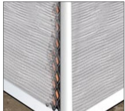
Wird ein zusätzlicher Armierungsputz mit Gewebeeinlage aufgebracht, ist zu prüfen, ob vorhandene Putzprofile hierfür passen. Ist das der Fall, sollten verschmutzte Abziehkanten der Profile bei Bedarf gereinigt werden. Sind keine passenden Putzprofile vorhanden, können zusätzliche Profile auf den Unterputz aufgebracht werden oder die Kanten der Armierungsputzlage werden von Hand hergestellt.
