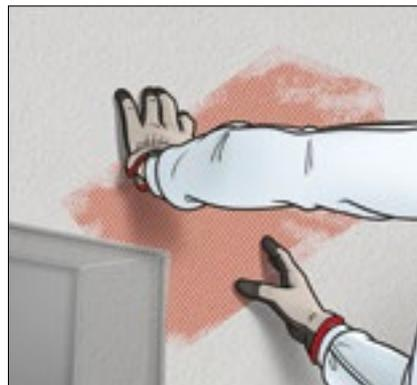
Grundsätzlich sollte vorbereitend im Bereich aller Gebäudeöffnungen, wie z. B. Tür- und Fensterecken, ein zusätzliches Diagonalarmierungsgewebe eingespachtelt werden, um einer Rissbildung in diesen Bereichen vorzubeugen. Alle zusätzlichen Armierungen werden generell unter der Flächenarmierung eingebaut.
