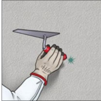
**2** Bei Anzeichen oder einem Verdacht ist die Oberfläche auf Hohlstellen zu prüfen, siehe Kasten. Sind Hohlstellen größer als eine Handfläche vorhanden, müssen diese behoben werden. Dazu wird der Putz der betroffenen Teilflächen entfernt und diese werden neu verputzt.
