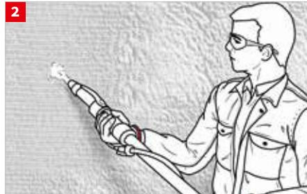
Unterputz von Hand oder mit der Maschine auftragen und mit einer Zahntaufel oder Kartätsche verziehen.
