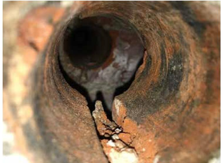
Treibmineralneubildung (weiße Minerale) zwischen den Mauerwerksschalen, aufgrund von Zementinjektionen im Mauerwerk
