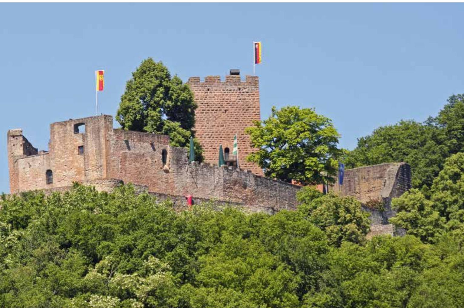
Der Kernbereich mit Palas und Bergfried gehört zur ursprünglichen Anlage, die spätestens seit 1237 besteht. Ab 1415 wurde der Burg zur Verstärkung der Wehrfähigkeit eine Zwingermauer hinzugefügt. In beiden Bereichen mussten Teile neu aufgemauert werden. Das Mauerwerk der Burg besteht aus rotem und gelbem Sandstein, der hauptsächlich aus der Umgebung stammt. Noch heute finden sich dort genügend erhaltene Steine für die aktuellen Sanierungsarbeiten.
