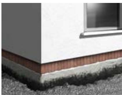
Mauerwerk (Sockel ungedämmt)
