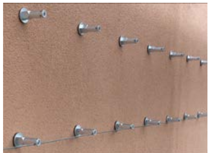
Fassadenbegrünung mit akurit ISO-BAR ECO
