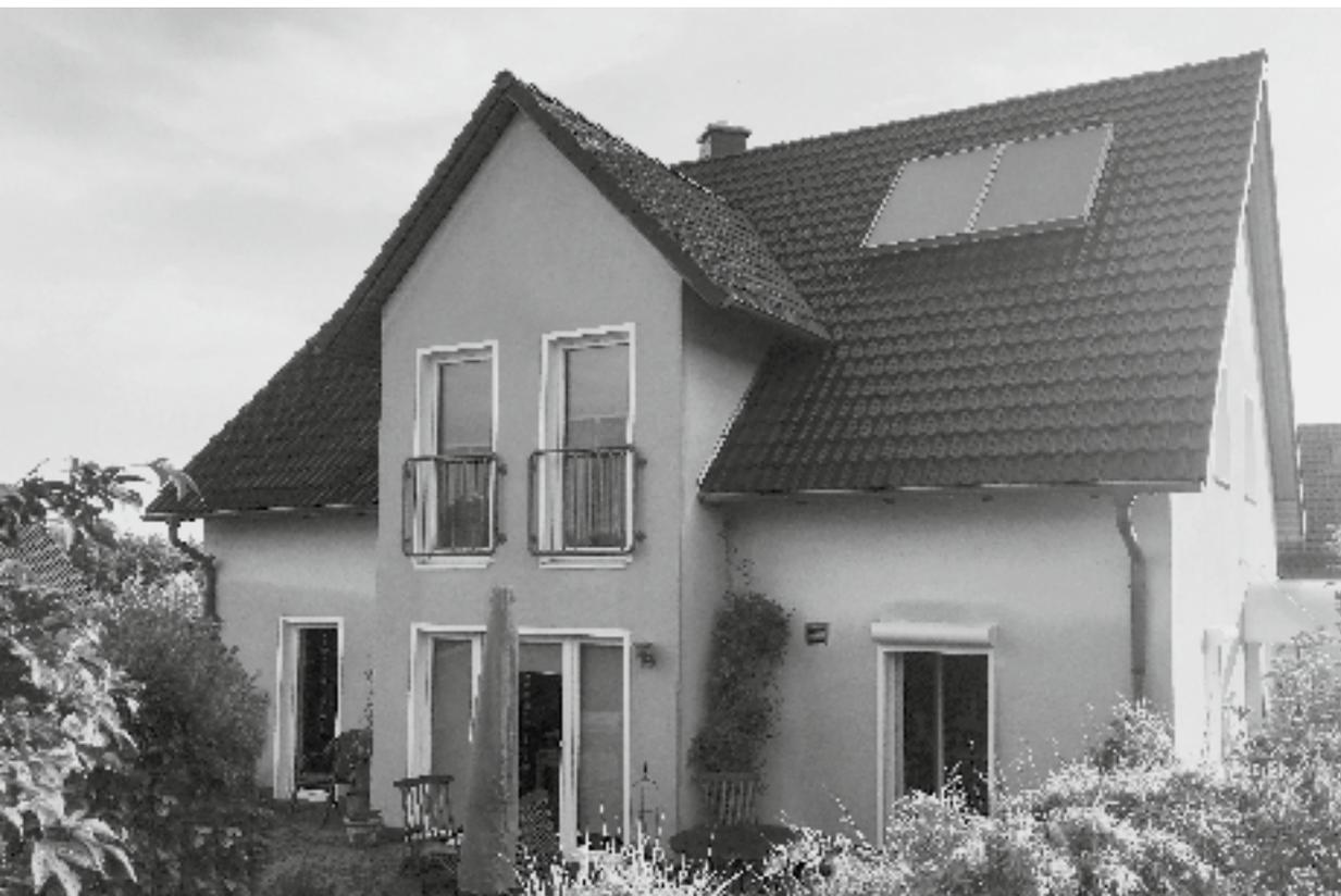
Fassade mit mineralischem Putzsystem ohne wasserabweisendes Anstrichsystem nach einem Regenschauer
