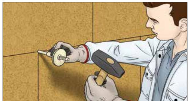
**2** Nach mindestens einem Tag, besser zwei Tagen Trocknungszeit erfolgt die eigentliche mechanische Befestigung mit einer Mindestverankerungstiefe von  $\geq 25$  mm. Die Tellerbefestiger werden in den Stoßbereichen montiert. Details zur Befestigung sind den Verarbeitungsrichtlinien der Holzfaser-Hersteller zu entnehmen.
