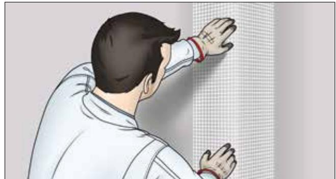
**4** Um Risse im Inneneckbereich zu vermeiden, kann ein AKURIT GEB Eckwinkel Brandschutz in das Eck eingesetzt und nass in nass in die Armierungslage eingearbeitet werden oder eine Putztrennung mittels Kellenschnitt erfolgen. Danach wird die Oberfläche des AKURIT KSN Kalkspachtel Natur mit einem Schmetterling abgeglättet.
