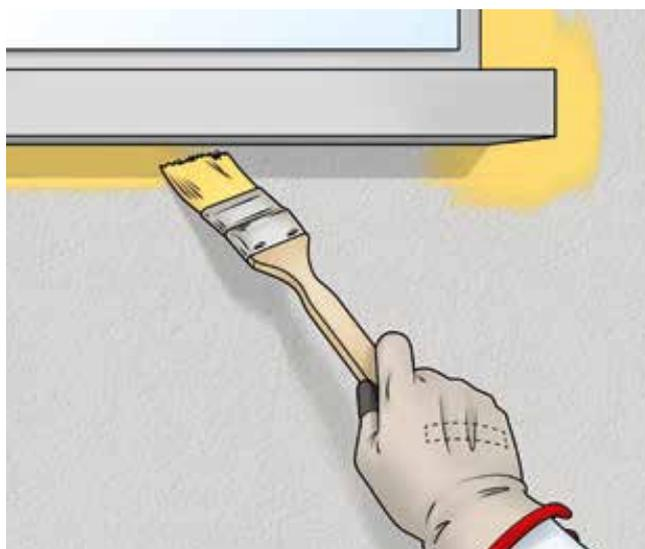
**1** Randbereiche der Fassade, z. B. unterhalb der Fensterbänke, werden vorgestrichen und danach nass in nass mit in die Überarbeitung der Fläche einbezogen.
