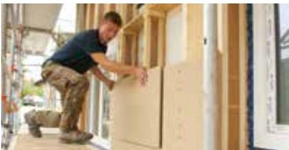
Nut-und-Feder-Platten werden endlos verlegt, bei Holzrahmenkonstruktionen auch mit schwebendem Stoß horizontal und mit der Feder nach oben. Der Mindestversatz der senkrechten Plattenstöße darf 25 cm nicht unterschreiten.
