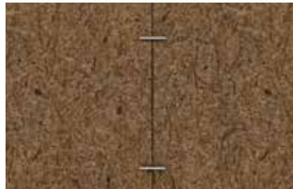
Bei Nut-und-Feder-Platten ist eine mittige, einreihige Klammerbefestigung über den Stoßbereich hinweg (Stoßvernähung) nicht zulässig. Das Vernähen des Plattenstoßes ist nur bei stumpfer Kantenausbildung möglich.
