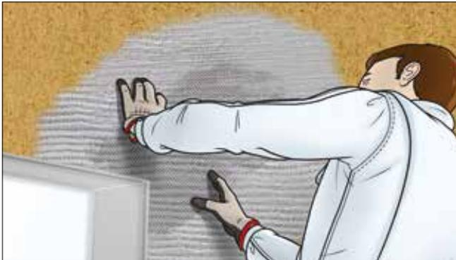
**1** Bei allen Öffnungen ist es notwendig, an den Ecken einen Gewebepfeil oder Gewebestreifen mit ca. 30 × 30 cm am Eck beginnend einzubetten und die Innenecken von Sturz und Laibungen zusätzlich mit einem Gewebestreifen zu armieren.
