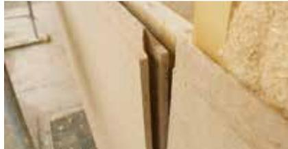
Bei Nut-und-Feder-Platten sind beide Seiten aus Gründen der Verschnittoptimierung geschliffen. Obwohl das Nut-und-Feder-Profil symmetrisch ist, können geringfügige Abweichungen zusätzliche Schleifarbeiten notwendig machen. Zur Verschnittoptimierung können sowohl die Nass- als auch die Trockenplatten gedreht werden.
