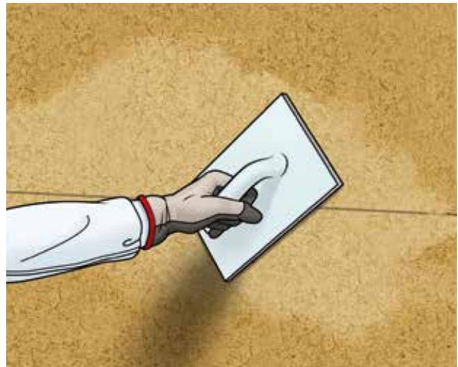
**2** Schleifen: Bestehende Unebenheiten oder Dickenversätze der Holzfaser-Dämmplatten sind mit dem Schleifbrett (K16) zu egalisieren. Die Oberfläche von abgewitterten und/oder UV-geschädigten Dämmplatten muss bis auf die tragfähige Schicht abgeschliffen werden.
