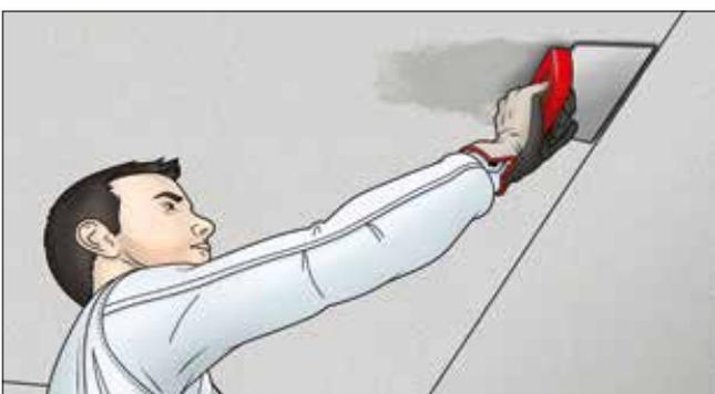
**5** Der Übergang von Wand zu Decke wird mit einem horizontalen Trennschnitt ausgeführt.
