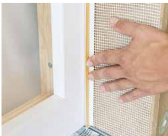
Aufgrund der häufigen Gewerketrennung zwischen der Montage der Platten und dem Aufbringen des Putzsystems hat es sich in der Praxis bewährt, Fensteranschlussprofile mit integriertem Dichtband einzusetzen.
