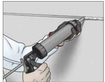
**3** Die Wandansatz-, Boden- und Deckenfugen werden mit Acryl gefüllt.
