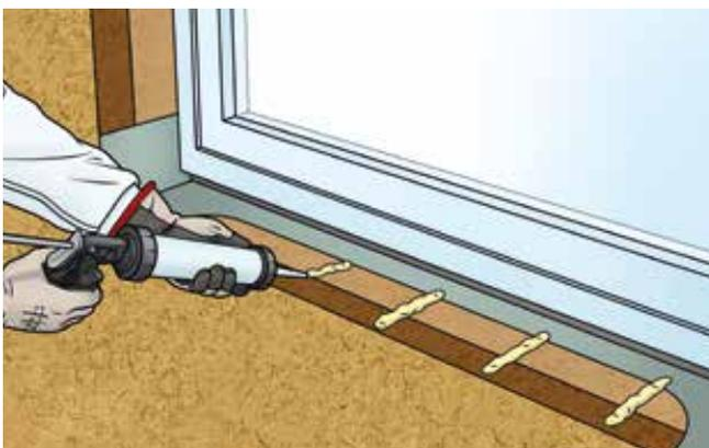
**5** Auf die Brüstungsabdeckung werden AKURIT-WF-Multifill-ST-Raupen aufgetragen, die in einem Abstand von ca. 30 cm vom Fenster nach außen führen.
