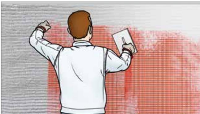
**3** Anschließend wird das Armierungsgewebe faltenfrei, oberflächennah und mit einer Stoßüberlappung von 10 cm eingebettet. Weiteres Material mit der Zahntraufel aufziehen und horizontal aufkämmen. Vor weiterem Oberputzauftrag Standzeit beachten.
