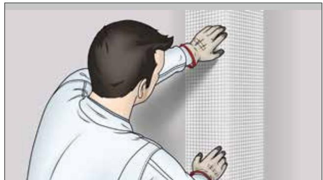
**4** Um Risse im Inneneckbereich zu vermeiden, kann ein AKURIT GEB Eckwinkel Brandschutz in das Eck eingesetzt und in die noch nasse Armierungslage eingearbeitet werden. Oder es erfolgt eine bewusste Putztrennung mittels Kellenschnitt. Diese Fuge kann dann vor den Anstricharbeiten mit Acryl verfüllt werden.
