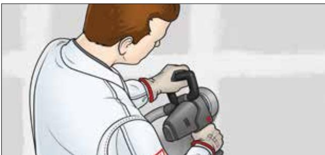
Ist die Spachtelmasse getrocknet, wird die Wand entweder manuell oder maschinell geschliffen.
