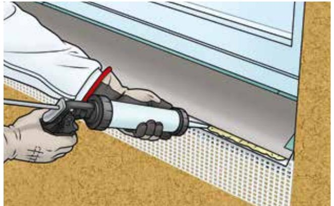
**8** Der Folienüberstand des Dämmkeils wird mit AKURIT WF Multifill ST auf die Tropfkante des Attikaprofiles verklebt.
