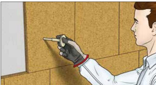
**1** Die Tellerbefestiger in der Plattenmitte können bereits während des Anbringens der HWF-Holzfaserdämmplatten gesetzt werden und führen zu einer ersten Fixierung der Dämmplatten. Es empfiehlt sich ein Vorbohren der HWF-Holzfaserdämmplatten mit einem 10-mm-Holzbohrer.
