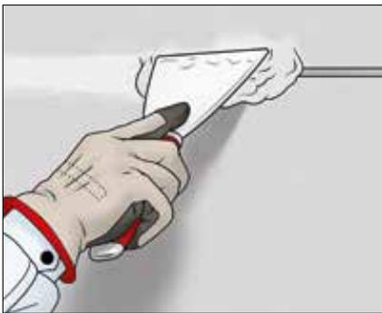
**1** Vor dem Verputzen ist die Oberfläche mit geeignetem Material sorgfältig zu verspachteln, um Fugen zu schließen.
