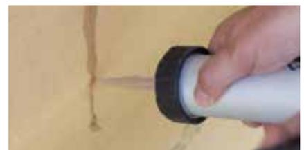
Die Dämmplatten sind passgenau im Verband zu befestigen. Unvermeidbare Fugen oder Fehlstellen bis 5 mm Breite sind mit druckfester Dichtmasse, z. B. AKURIT WF Multifill ST, zu schließen. Ab 5 mm ist mit Holzfaser-Dämmstoff zu arbeiten.
