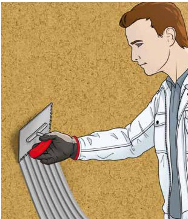
Die zulässigen Verarbeitungstemperaturen liegen im Bereich +5 °C bis +30 °C, das gilt für die Luft- und Bauteiltemperatur während der Verarbeitung und Erhärtung.
