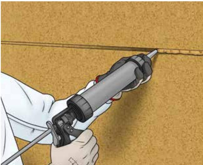
**1** Fugen/Dämmstofffehlstellen: Mit etwaigen Fugen oder Dämmstofffehlstellen ist wie folgt zu verfahren: Unvermeidbare Fugen oder Fehlstellen von bis zu 5 mm Breite sind mit druckfester Dichtmasse, zum Beispiel AKURIT WF Multifill ST, zu schließen. Ab 5 mm ist mit Holzfaser-Dämmstoff zu arbeiten.
